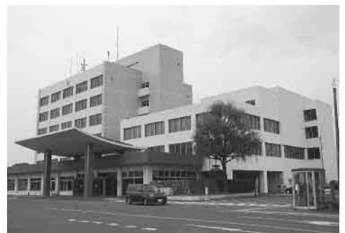
▶耐震化工事が急がれる市庁舎
