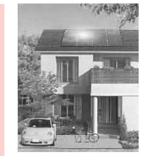
▲家庭用太陽光発電パネル
