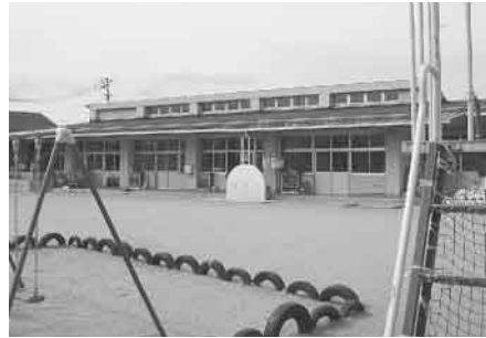
▲仮設園舎が設置される増田保育所
