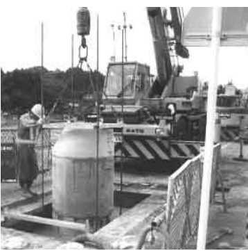
公共下水道工事
