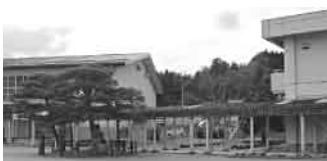
▲仮設校舎設置予定の愛島小学校
