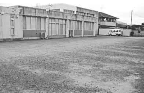
▲舗装が待たれる愛島公民館駐車場
