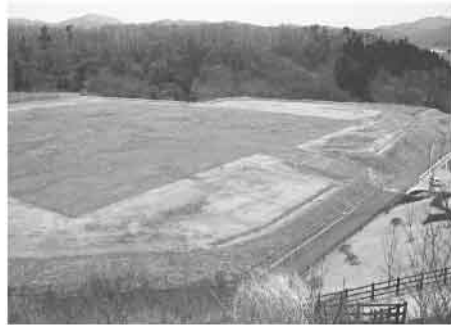
▲相互台東地区の中学校建設用地
