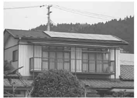
▲太陽光発電システムを設置している住宅
