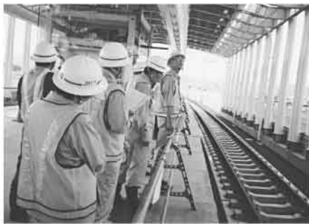
▲来春開業に向け工事が進む杜せきのした駅
