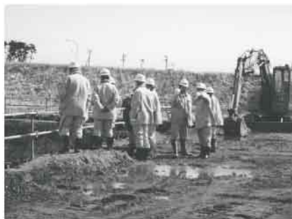
▲下増田雨水ポンプ場を調査
