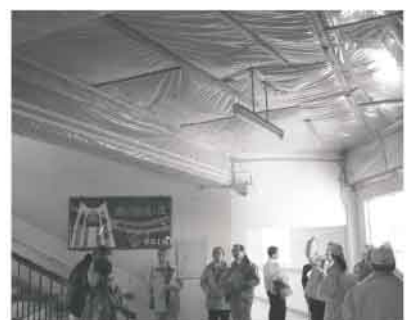
▲不二が丘小学校のアスベスト箇所の調査
