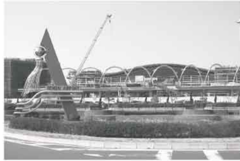
▲アクセス鉄道の工事が進む仙台空港
