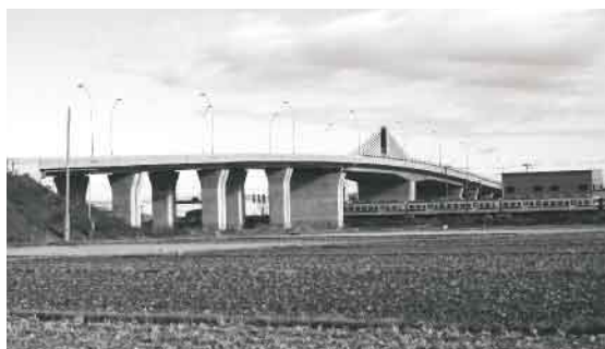
▲平成18年度中の完成を目指す館腰愛島線(館腰跨線橋)
