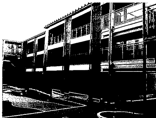
図 2 上中島復興公営住宅
