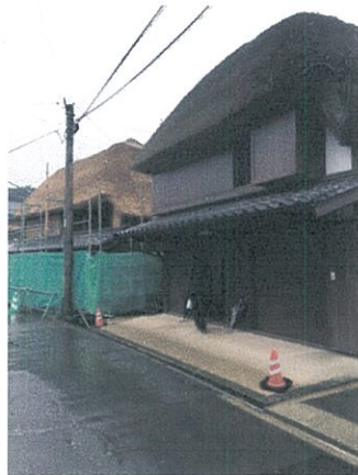
工事中と修復済
