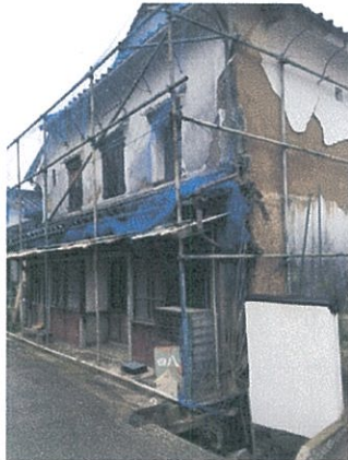
外装の修復工事
