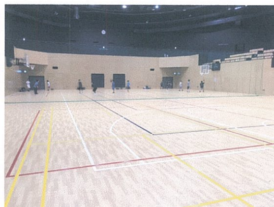
図3 サブアリーナの床(タラフレックスシート)
