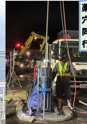
地中で固まる薬液を注入し地盤を固めて改良します。
