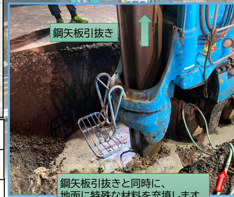
鋼矢板の引抜き状況です。
