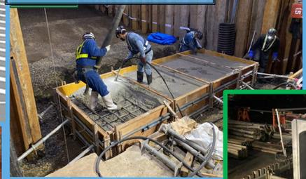
西側では排水構側溝を施工しています。
