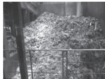
ごみピットの状況
