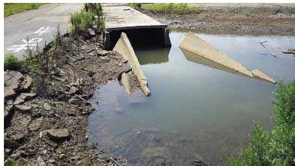
▲旧北上川の放流口が破壊された聖人堀
