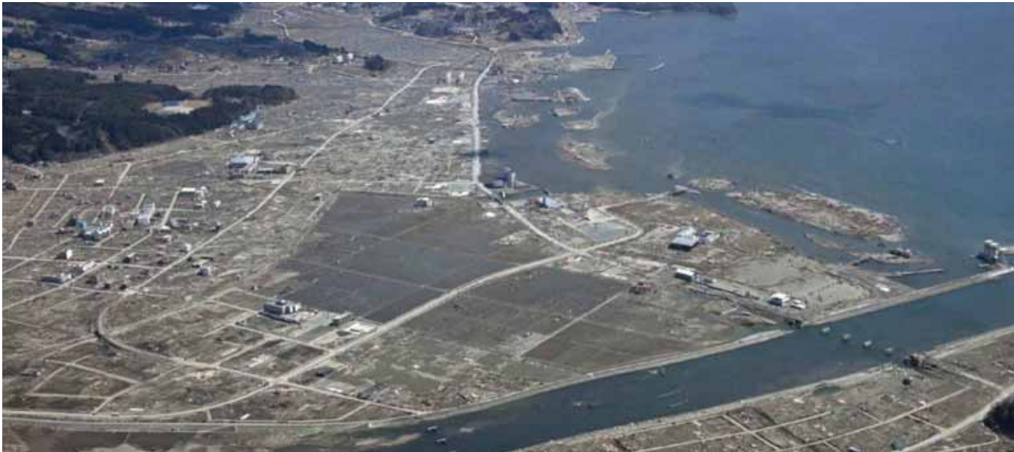
被災後写真： 平成23年3月28日撮影
