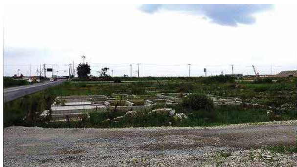
▲津波の破壊力を物語る建物の基礎
