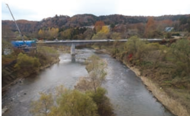
地下鉄東西線(広瀬川橋りょう外工区)
