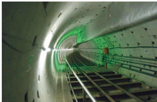
地下鉄東西線(薬師堂工区シールドトンネル)
