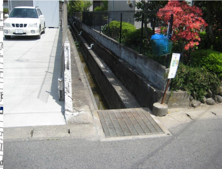
転落防止用の柵を設置する水路の状況(N-S)
