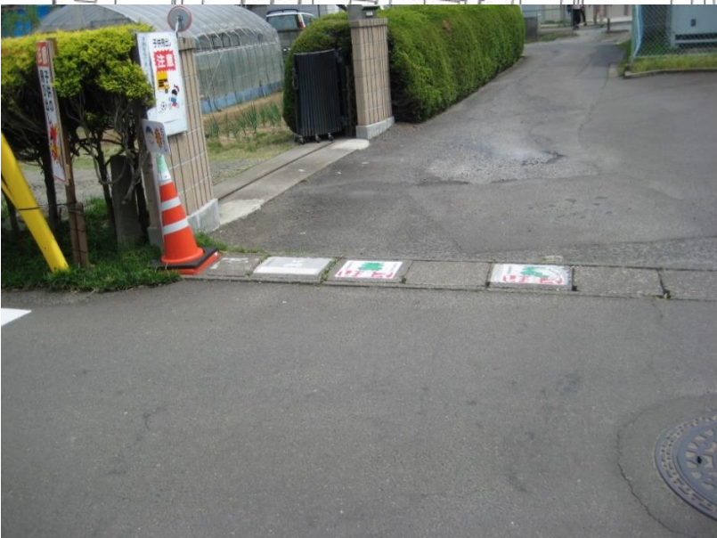
交換した標識版の状況(W-E)
