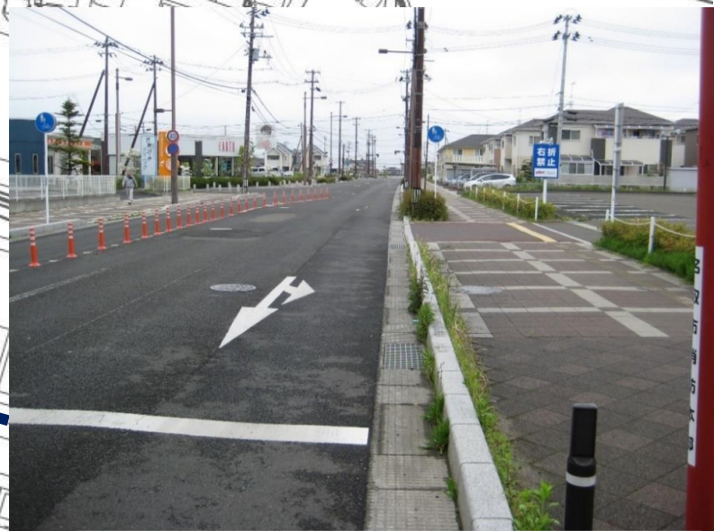
わだちを補修する道路南側状況(S-N)
