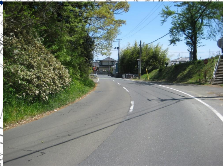
カーブを示す道路標示をするカーブ付近(W-E)
