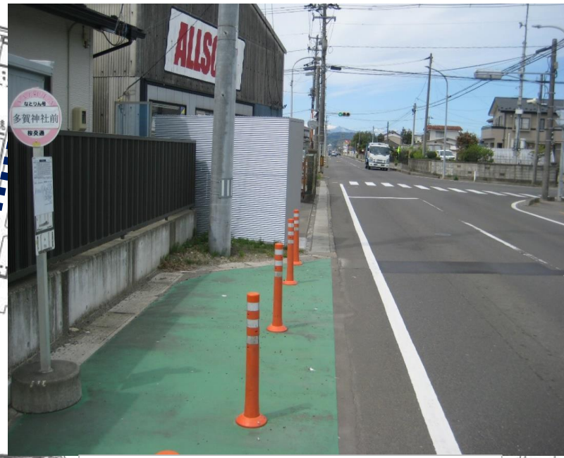
設置した分離標状況(E-W)
