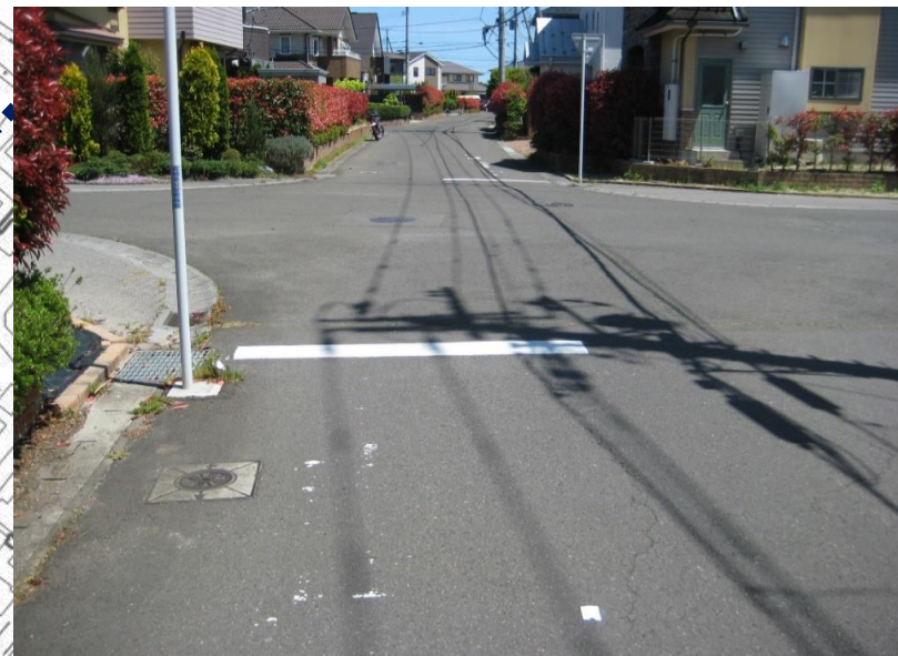
新設された停止線の状況(W-E)
