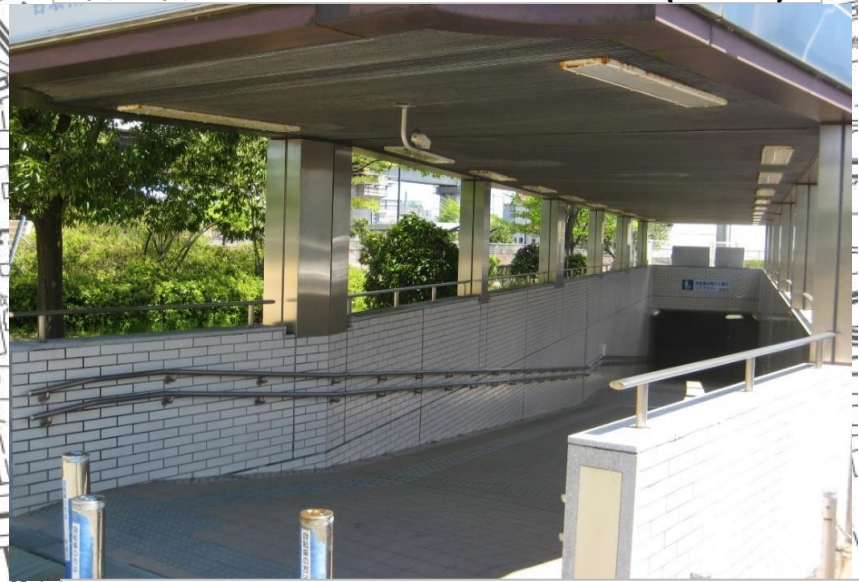
地下道入口付近の防犯カメラ設置状況(W-E)
