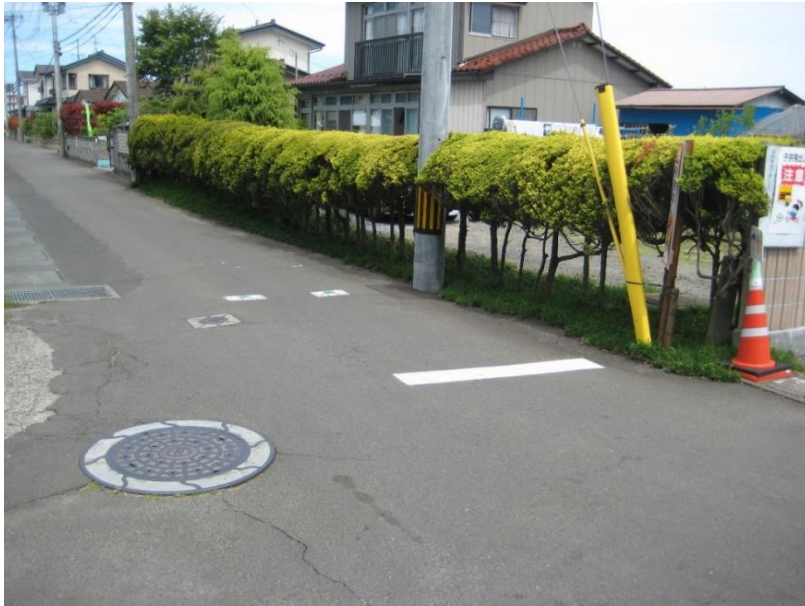
補修した停止線の状況(S-N)
