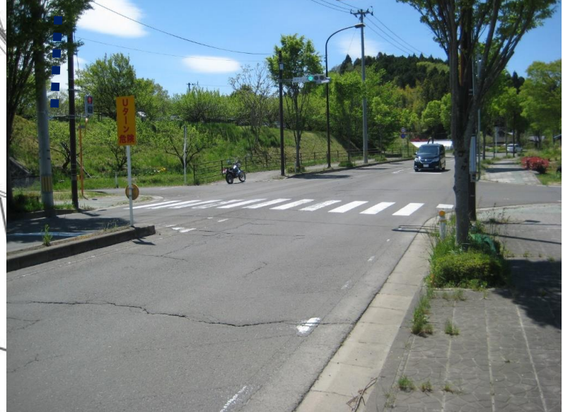
草木刈込後の交差点後の状況(E-W)
