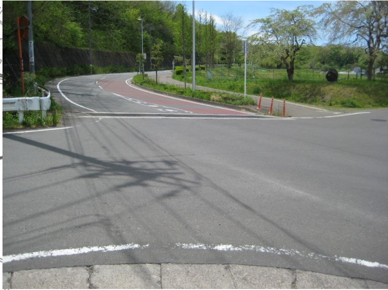
草木刈込後の交差点後の状況(E-W)
