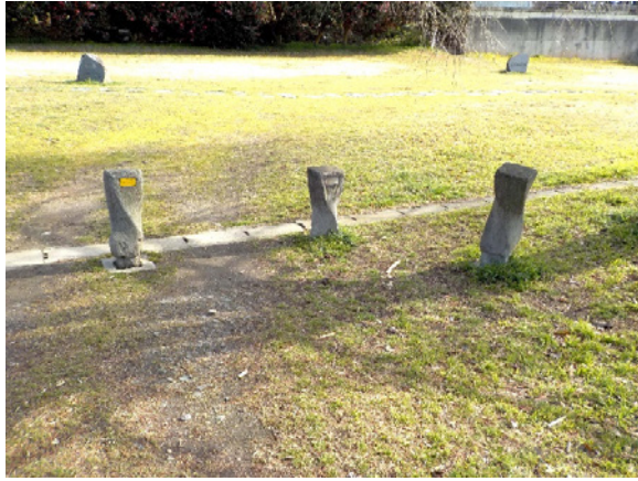
写真 36 劣化した車止め
