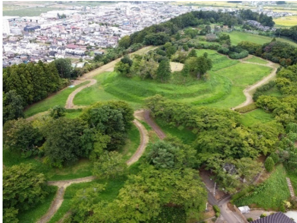
写真 38 史跡全体に繁茂する樹木類
